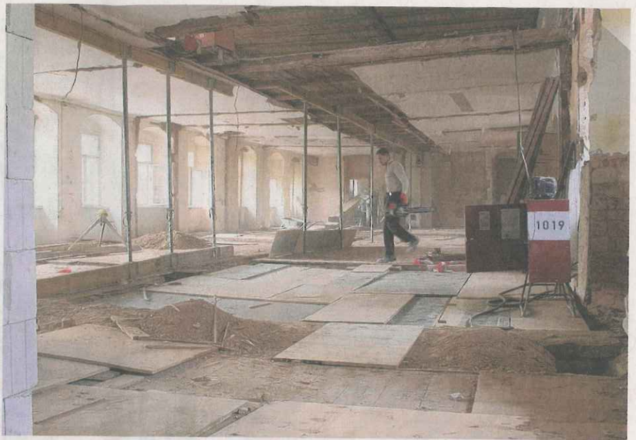
Staubige Baustelle: Im Ostflügel des Schlosses werden die Etagen weitgehend entkernt, auch die hölzernen Decken sind hier kaum zu erhalten. Foto: André Neumann
